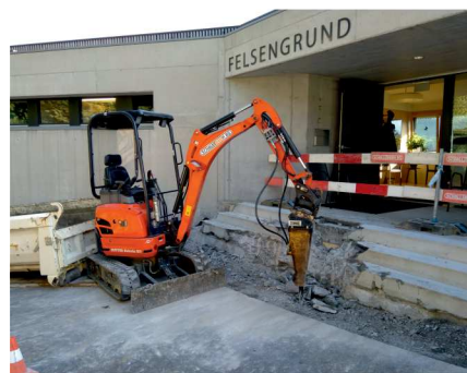
Sanierung der Haupteingangstreppe
