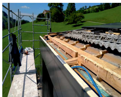
Wasserschaden wird behoben
